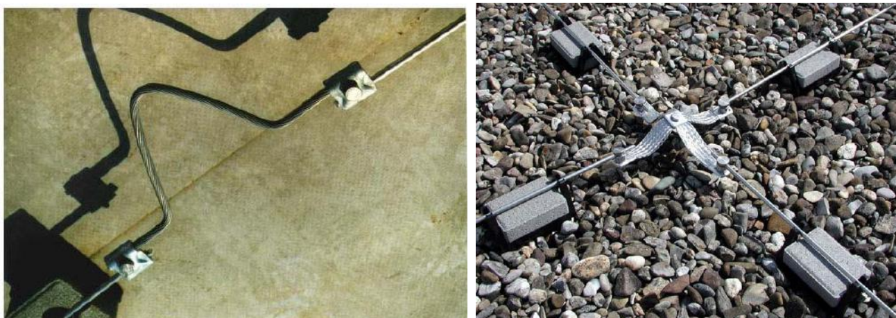
Рис. 6. Соединения, компенсирующие напряжения, возникающие при изменении температуры
