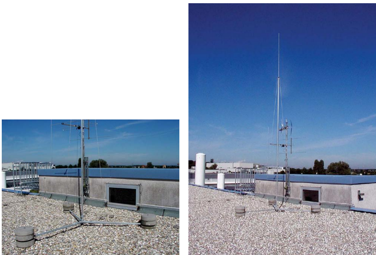
Рис.14 . Одиночные вертикальные молниеприемники [ ]
